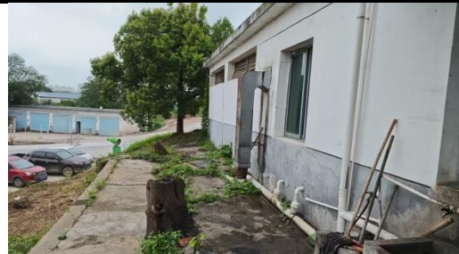
隔油池、化粪池（地埋式）
