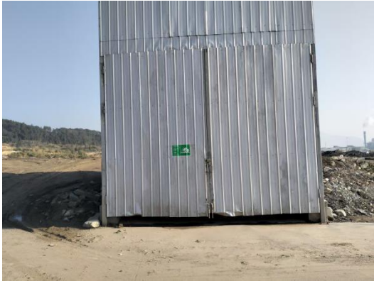
一般固废暂存间
