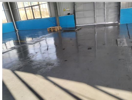
危废暂存间内油漆防腐地面
