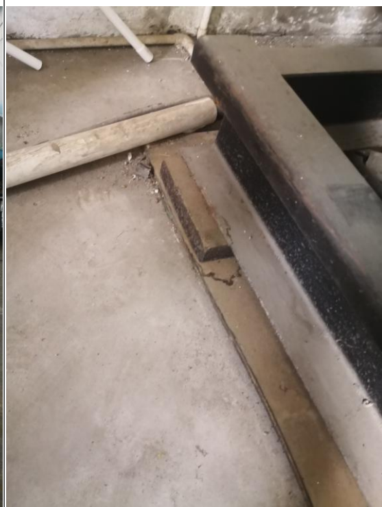
备用发电机底部隔声垫
