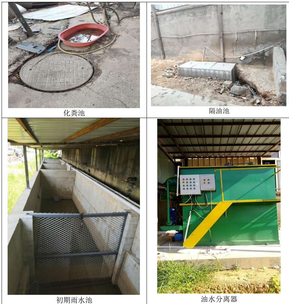
图 4.1-2 项目废水治理设施设置情况照片
