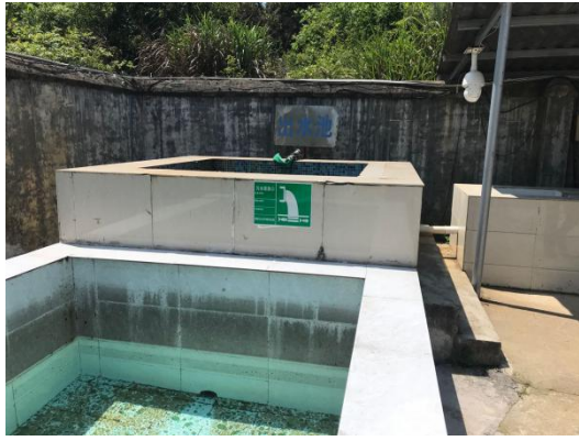
污水排放口标识牌
