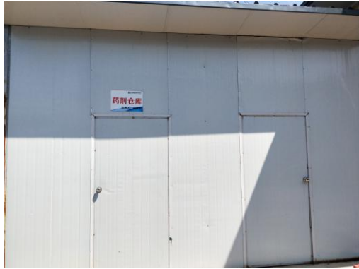
药剂仓库、废包装桶暂存库
