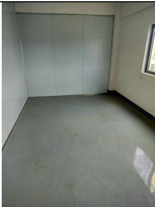
一般固体废物暂存间
