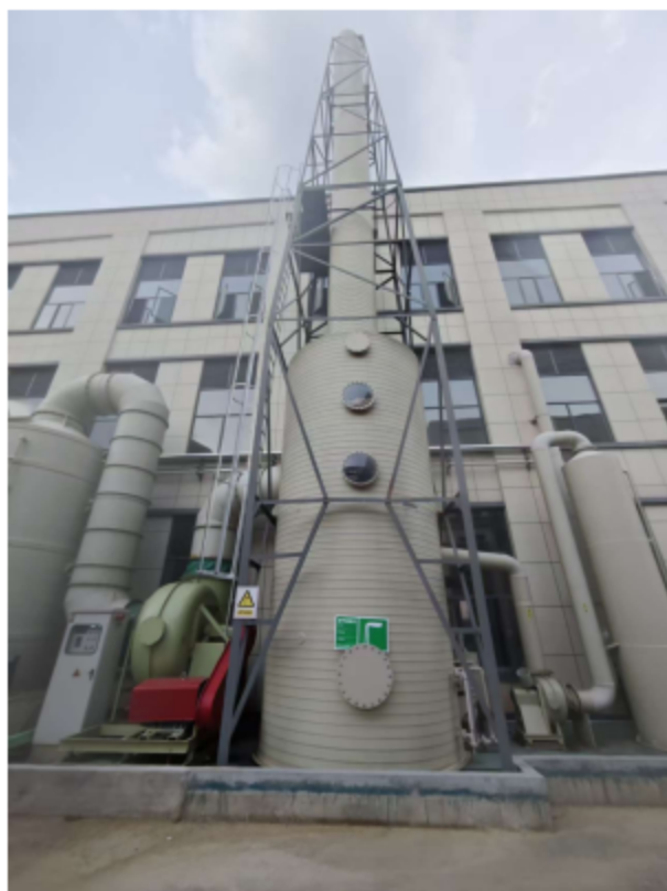
湿法一车间排气筒
