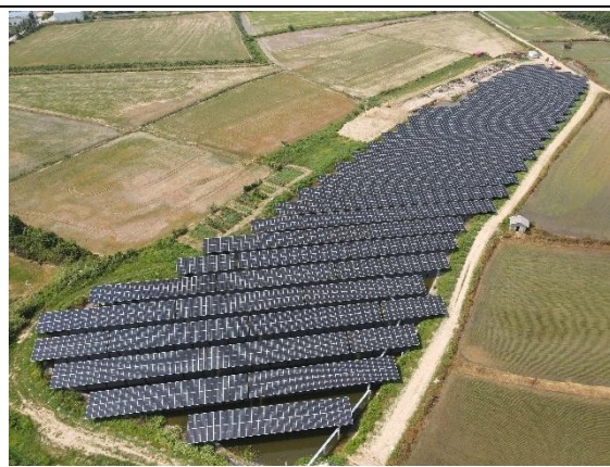
光伏区现状情况（21 地块）
