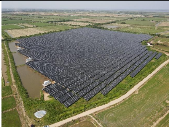
光伏区现状情况（5 地块）
