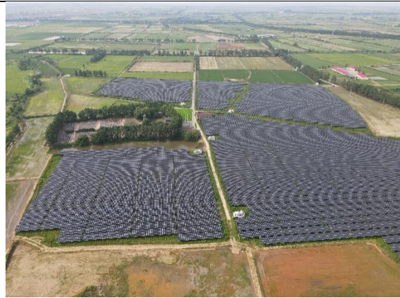
光伏区现状情况（6-10 地块）
