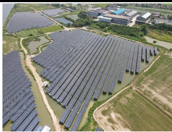
光伏区现状情况（15-18 地块）
