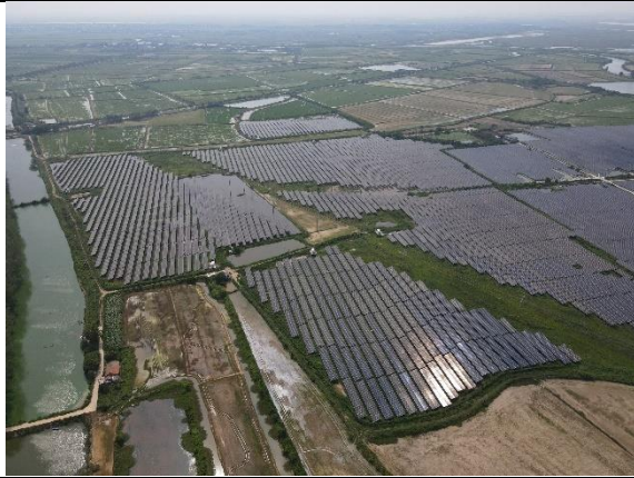
光伏区现状情况（1-3 地块）
