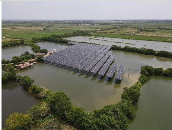
光伏区现状情况（11 地块）
