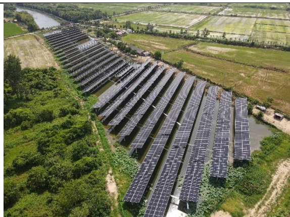
光伏区现状情况（19-20 地块）
