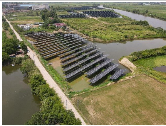
光伏区现状情况（11 地块）
