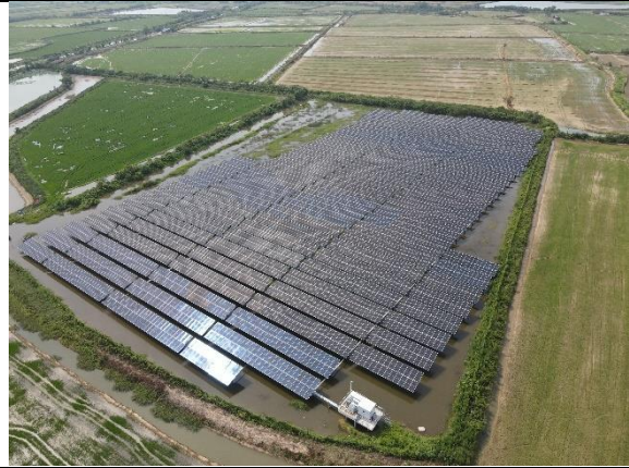
光伏区现状情况（4 地块）
