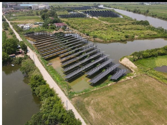
光伏区现状情况（12-14 地块）
