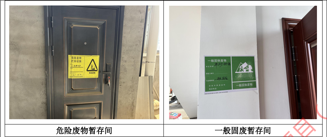
图3-3 危险废物处理设施
