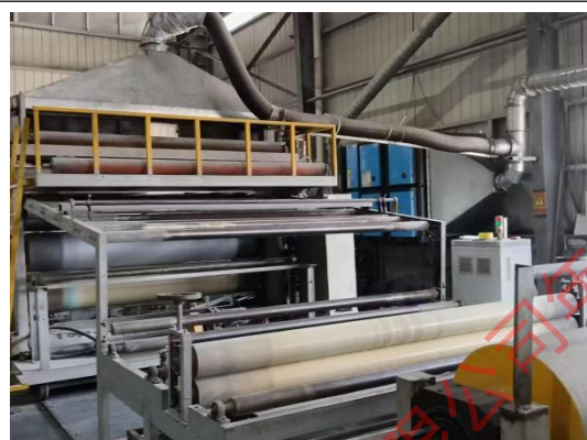
4#挤出车间：静电除油+UV光解净化器+一级活性炭吸附装置
