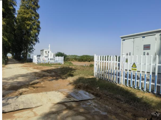
光伏区周边情况
