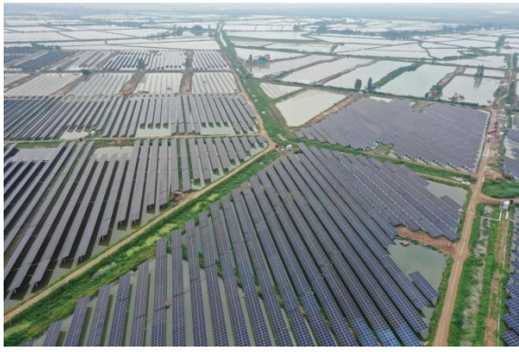
光伏区现状情况
