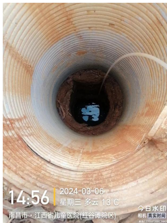
化粪池（传染病区废水）
