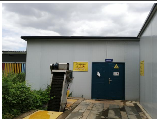
医疗废物暂存间
