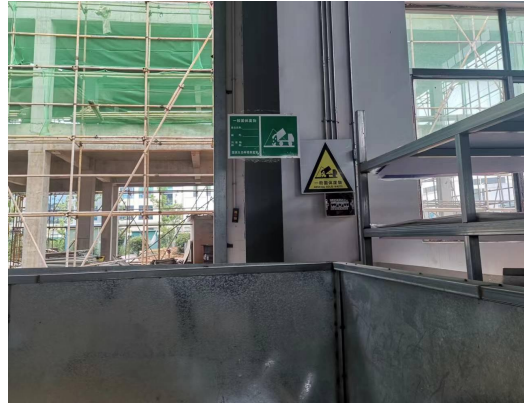
一般固废暂存场所
