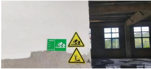
一般固废暂存处标识牌
