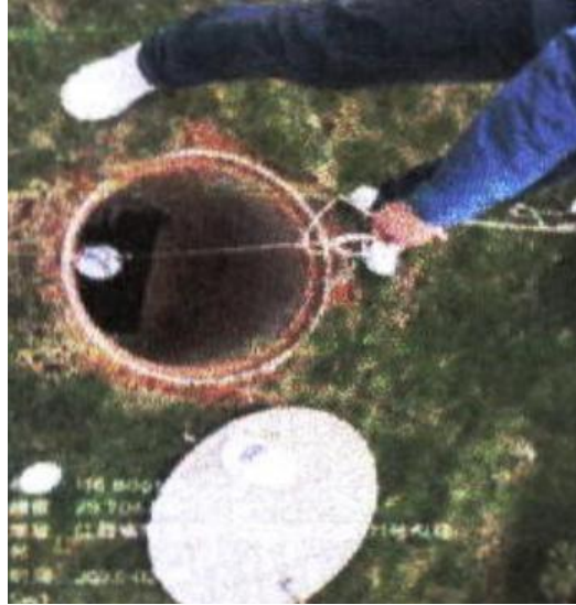
地下水监控井
