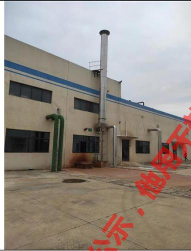
锅炉燃烧废气排气筒（DA002）
