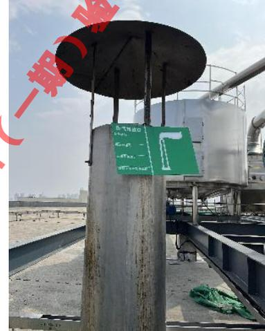
喷雾干燥废气排气筒（DA013）
