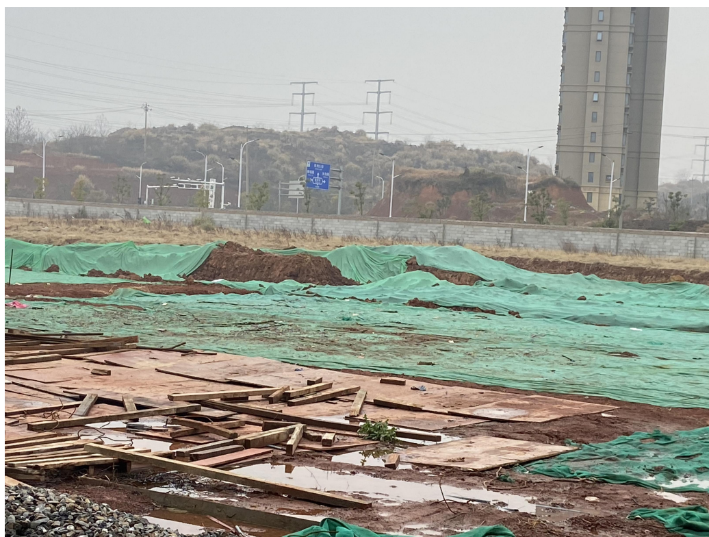
苫布覆盖（2020年11月施工单位提供）
