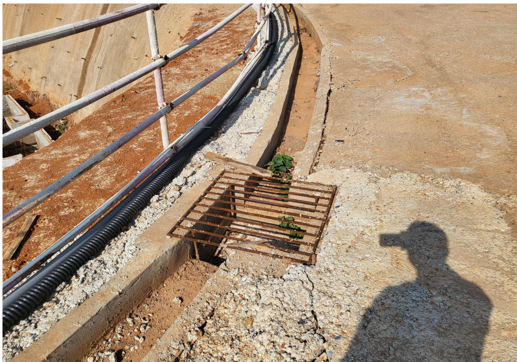
场地内临时沉沙池（2018年10月施工单位提供）
