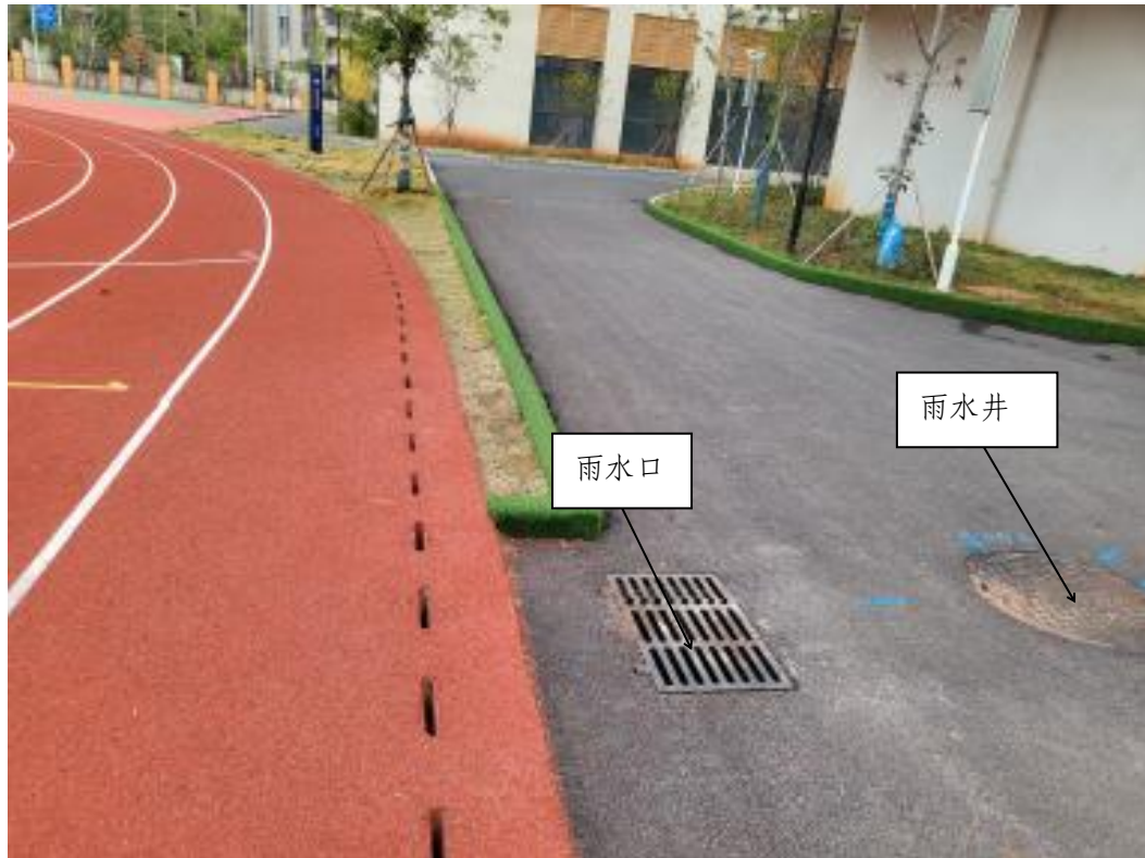
道路广场防治区雨水口、雨水井（2022 年 8 月）
