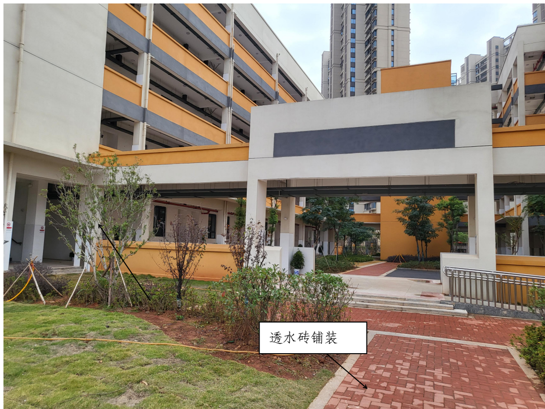
道路广场防治区透水砖铺装（2022 年 8 月）
