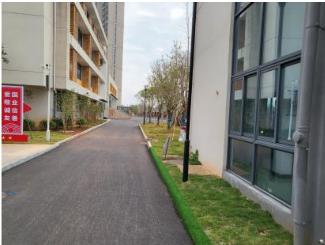
图 1.1-4 场地内道路建设情况（2022.12）
