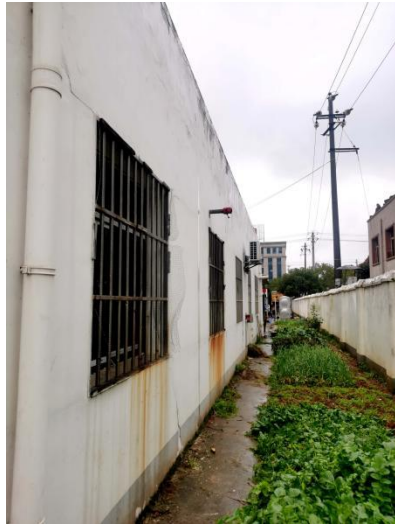
柴油发电机废气排放口
