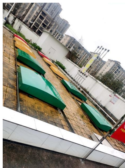
油气回收排气管
