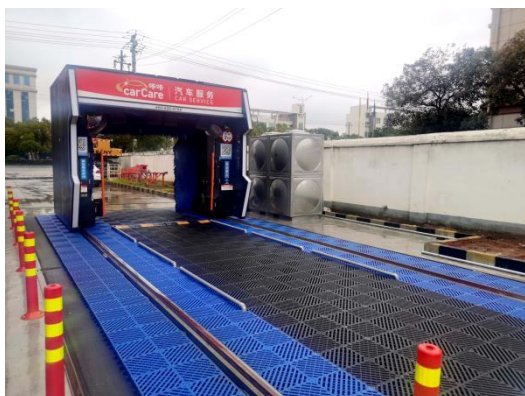
洗车污水净化系统
