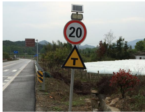
路段限速警示牌
