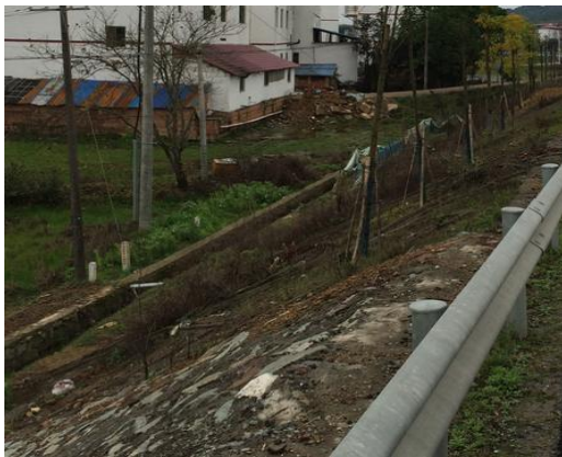
填方边坡格构防护
