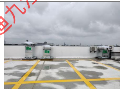
中涂、打磨工位废气排放口
