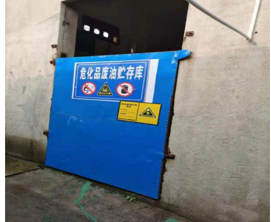
危险废物暂存处
