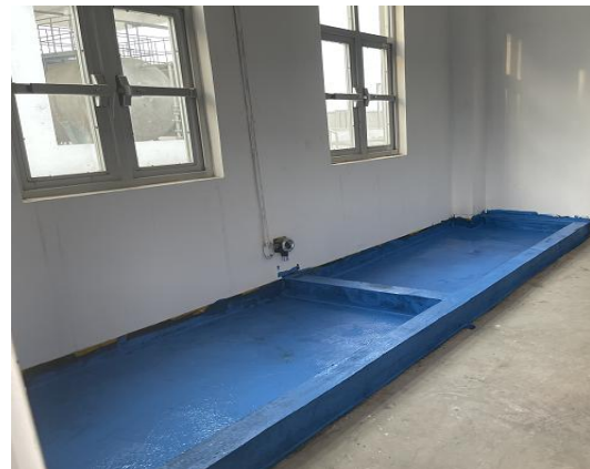
危险废物暂存间
