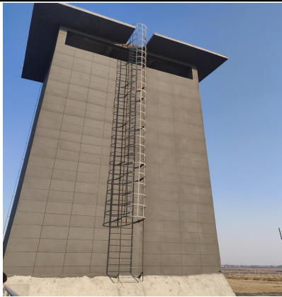
发动机试验尾气排放塔楼
