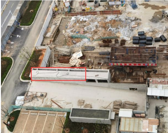
地下车库排烟口
