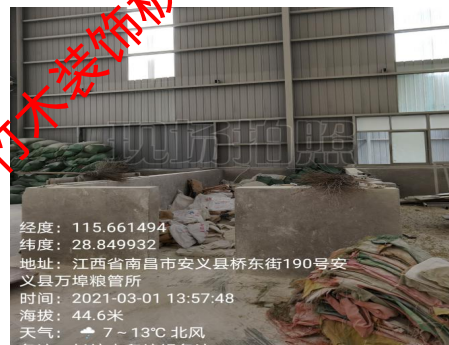
一般固体废物暂存处
